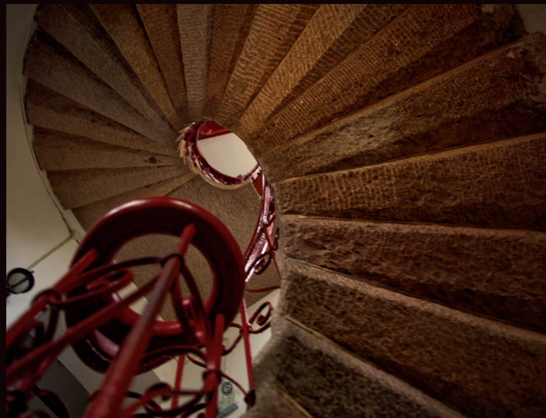
监狱旧址塔楼内的旋转楼梯采用了少有的石质阶梯
